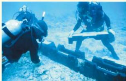
標準に配慮した海底ケーブルの敷設(沖縄電力)
