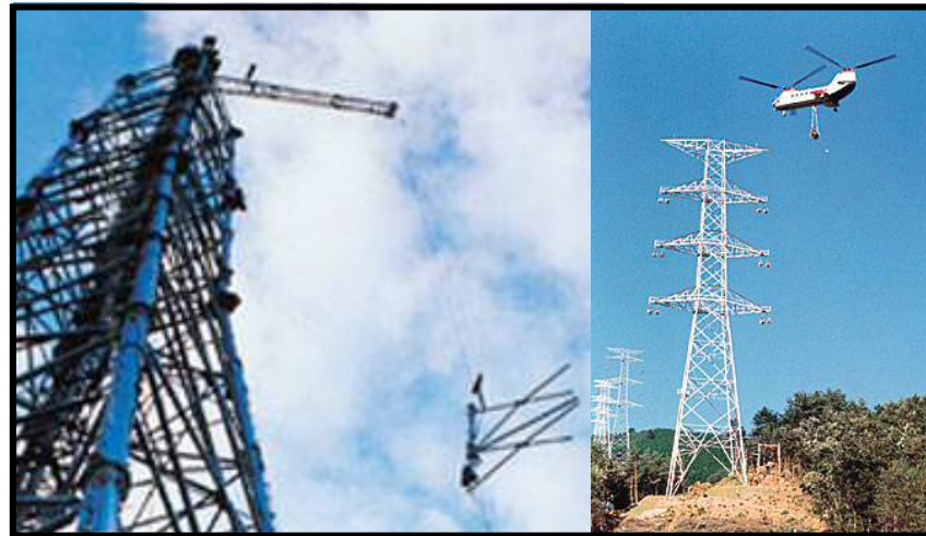
500kV送電線鉄塔の建設
