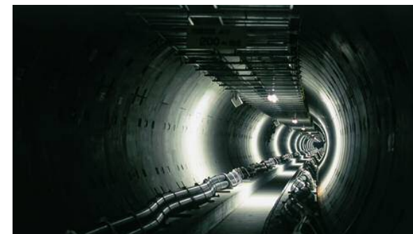
地中ケーブル(220kV広島中央線)
