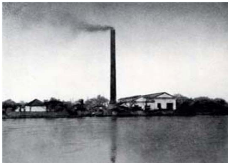
図. 浅草発電所全景
