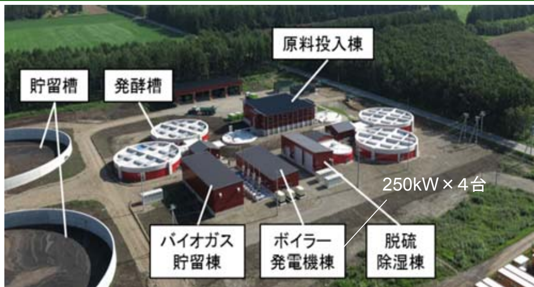
瓜幕バイオガスプラント (北海道電力(株)HPより)
